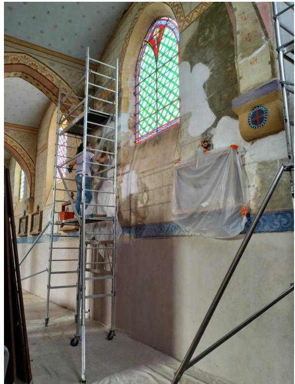
*Etat de conservation de la première travée avant restauration : empoussièremment et encrassement, taches d'humidité et modification des couleurs des peintures, nouveaux enduits réalisés par M. Cloix, fissures profondes...*
