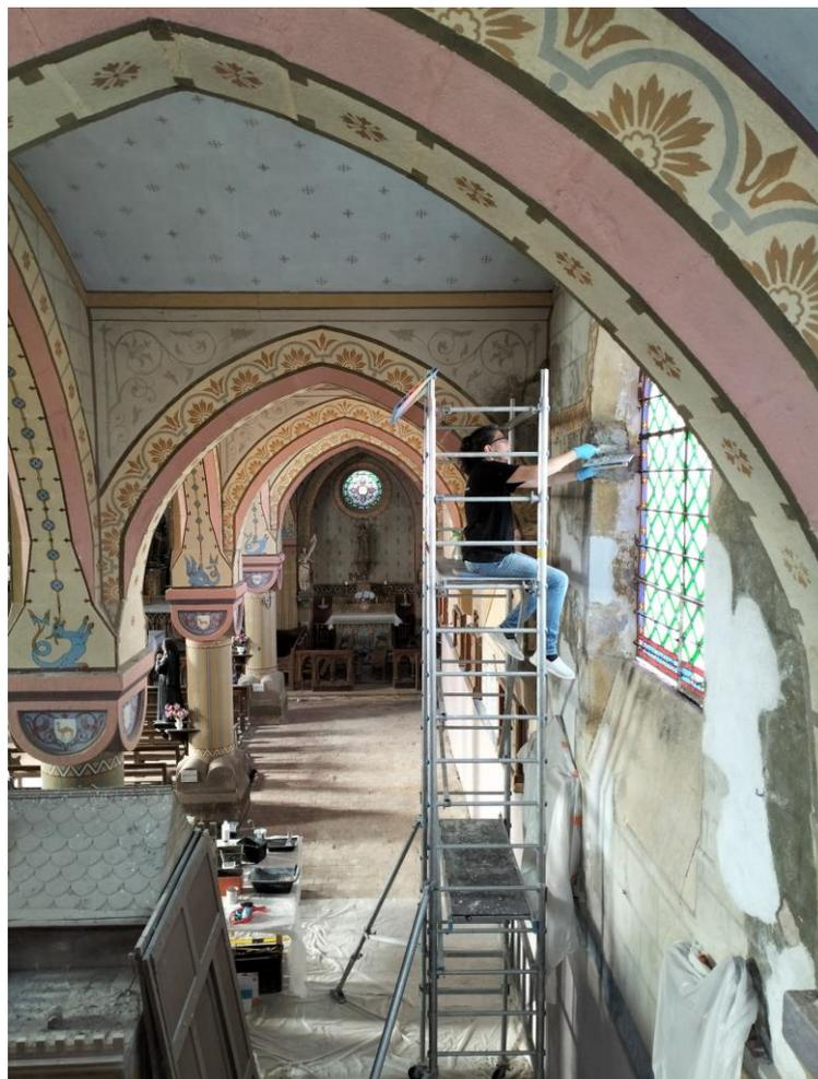
*Réalisation des bouchages à l'enduit de chaux*
