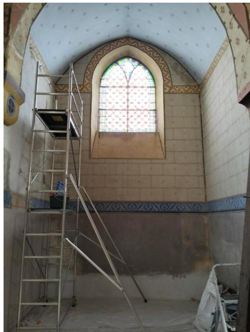
*Etat des murs avant restauration, avec les nouveaux enduits de chaux réalisés par M. Cloix*
