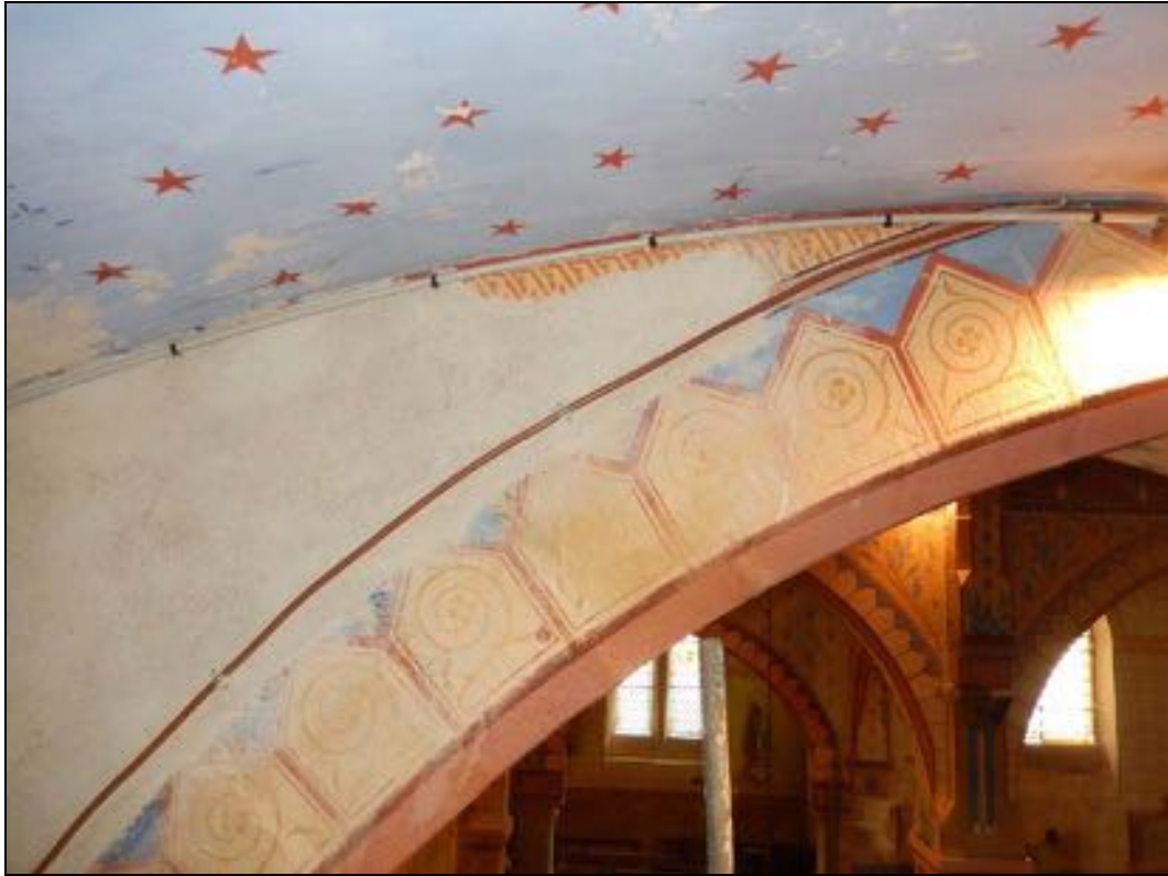
Reprise d'enduit par les maçons
