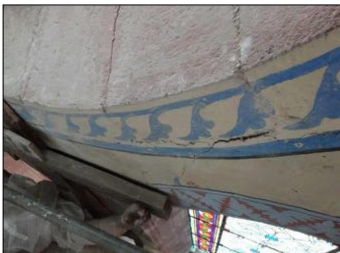
fig. 9 enduit décollé et fissuré
